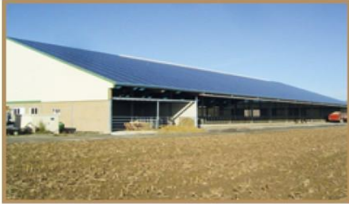
Toiture photovoltaïque
